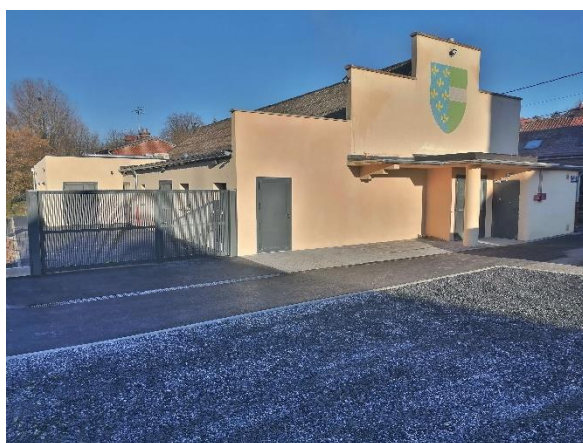
Vue d'ensemble de la salle des fêtes suite aux travaux
