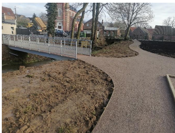
Mise en place d'une passerelle au-dessus de l'écaillon
